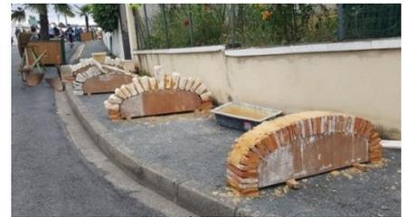
*Montage de voûtes en briquettes et à la chaux.*
